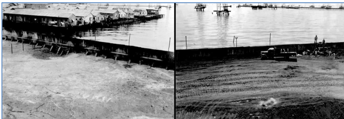
Figura 15: Fotografias tiradas do poço LS_1A, em direção ao oeste.
