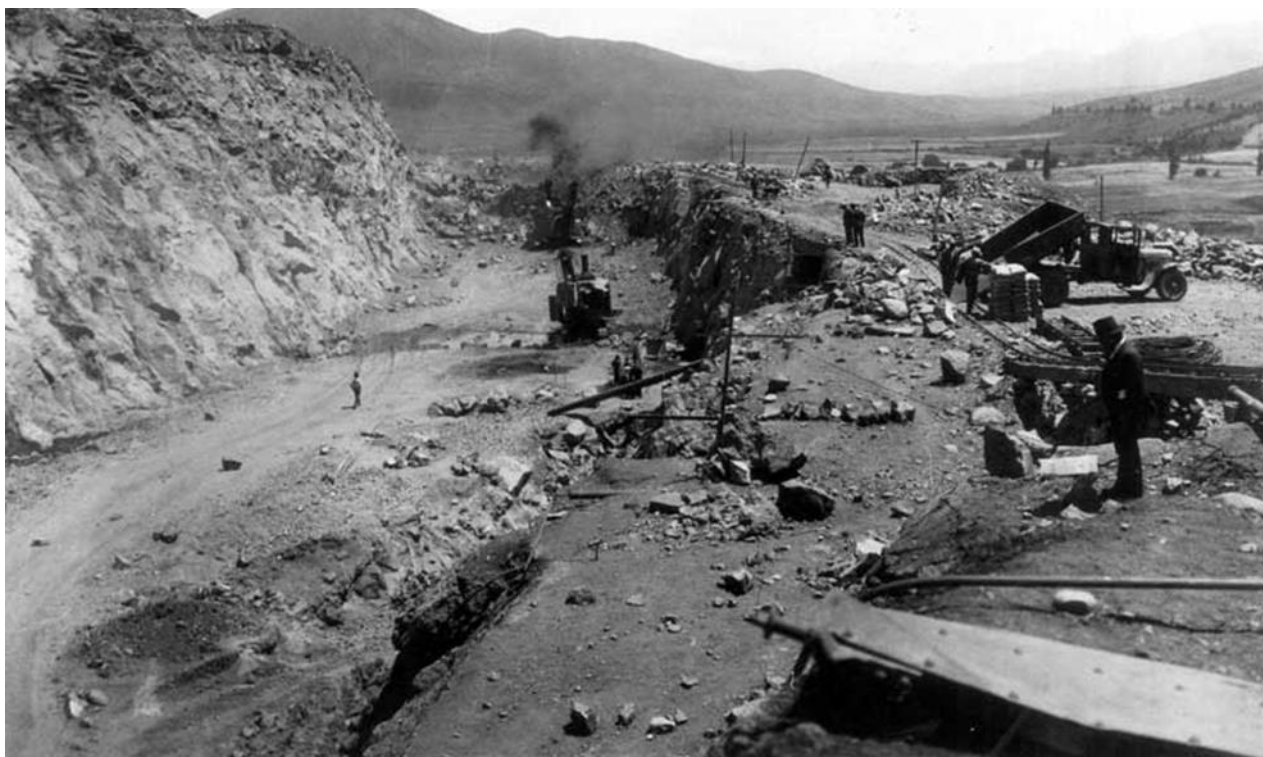
Figura 4. Construcción Embalse Recoleta
