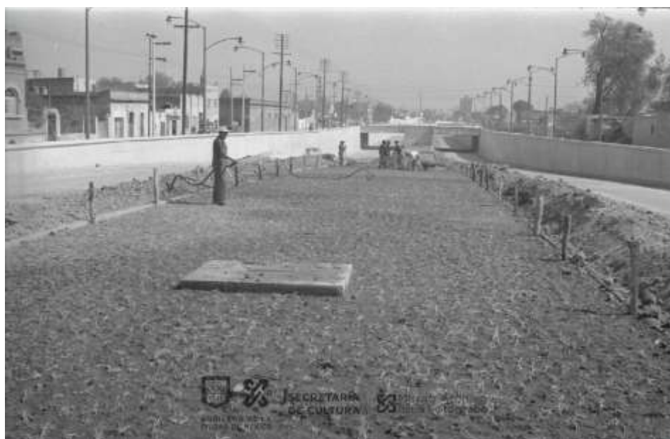
Figura 6. Viaducto Miguel Alemán sobre Río de la Piedad
