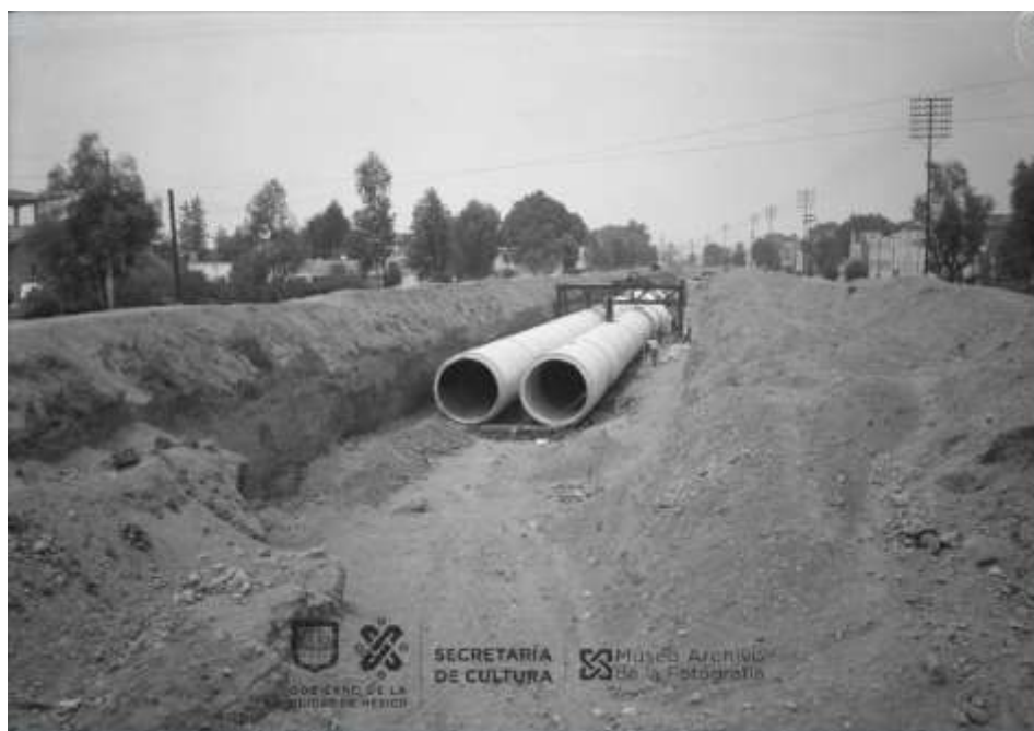
Figura 5. Entubación del Río de la Piedad a la altura de la Colonia del Valle.
