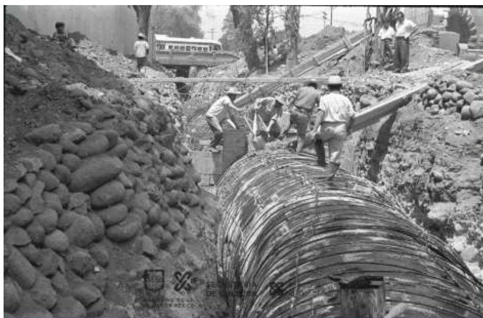
Figura 3. Entubación del Río Mixcoac.
